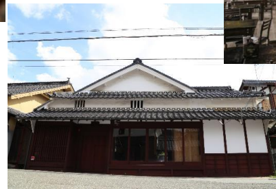
現況建物外観
