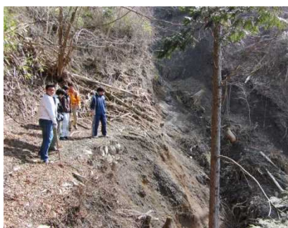
熊野古道小辺路の崩落現場
