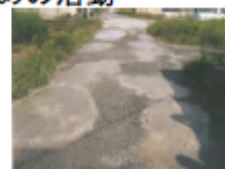
農道の窪みの補修
