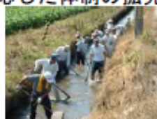
水路の泥上げ
