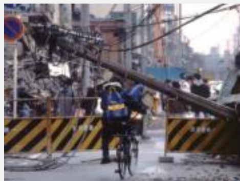
地震発生時の電柱の倒壊状況 （阪神・淡路大震災の例）
