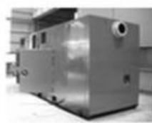
非常用発電設備
