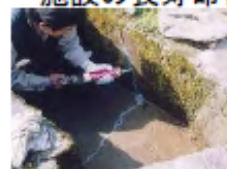
水路のひび割れ補修
