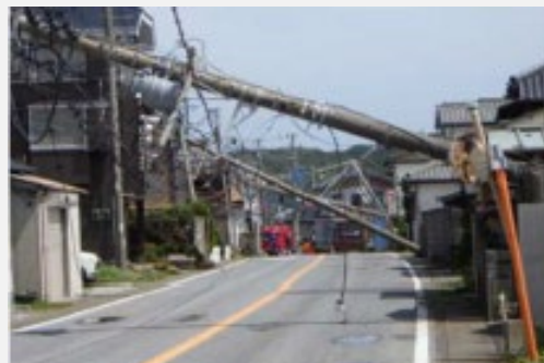
電柱が倒壊し、道路を閉塞した事例
