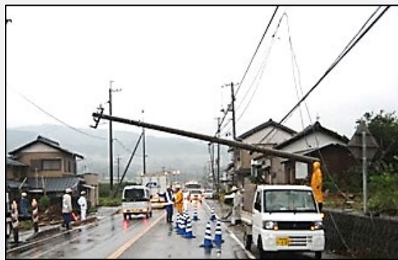
電柱が倒壊し、道路を閉塞した事例
