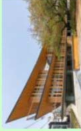
3層構成型耐火集成材を主要構造部に用いた事務所
