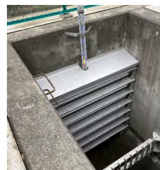
無動力減災ゲート 設置後の開口部
