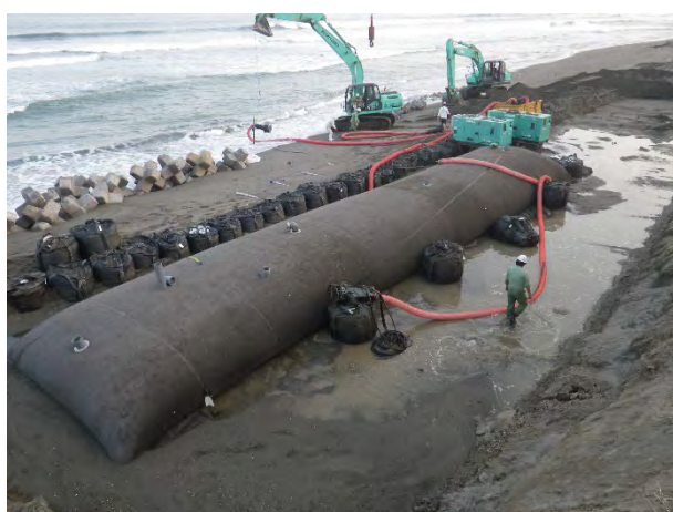
シーガーディアンを使用した海岸の後退抑止工法の様子
