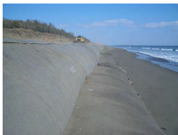
シーガーディアンを使用した海岸の後退抑止工法の様子
