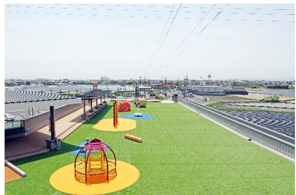
屋上広場の景況
