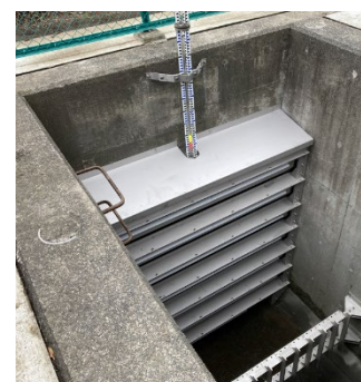
無動力減災ゲート 設置後の開口部
