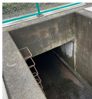
無動力減災ゲート 設置前の開口部
