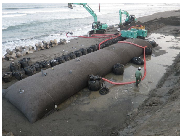
シーガーディアンを使用した海岸の後退抑止工法の様子
