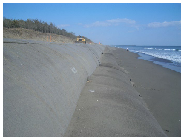
シーガーディアンを使用した海岸の後退抑止工法の様子
