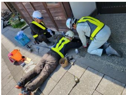
宅内配管復旧工事の様子
