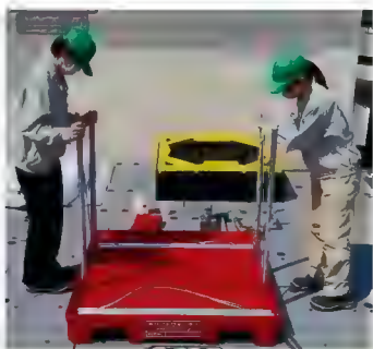
組立ての様子
