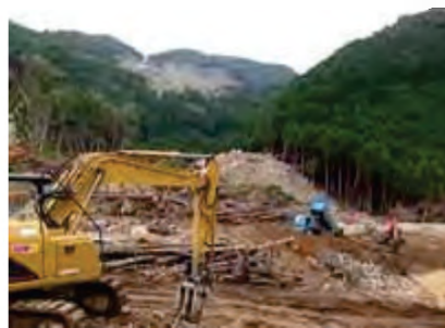
紀伊半島大水害の復旧作業
