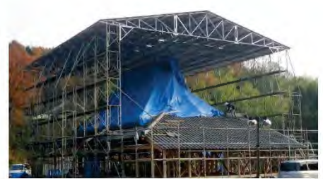
かやぶき屋根改修工事
