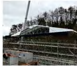
トラス取付作業
