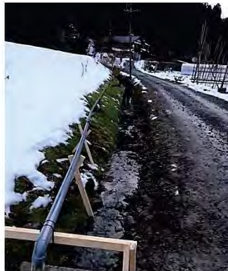
沢から水を引いた仮設水
