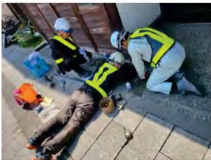
宅内配管復旧工事の様子
