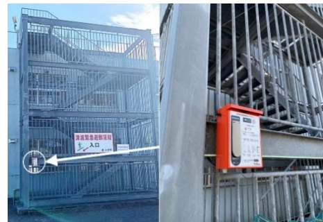
学校施設に設置された様子
