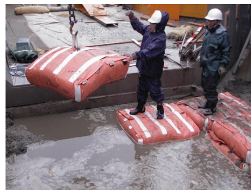
液状の土壌での施工
