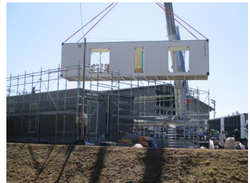
クレーンで設置する様子
