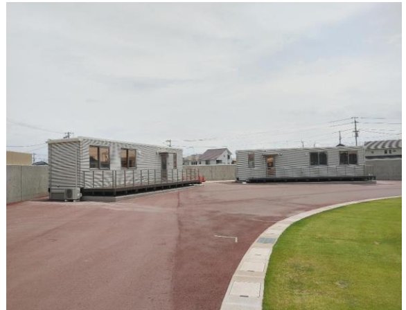
徳島県松茂町モバイル建築施設
