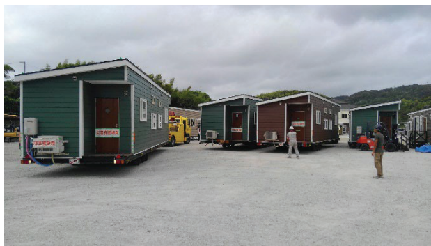
西日本豪雨における仮設住宅設置の様子（岡山県倉敷市）
