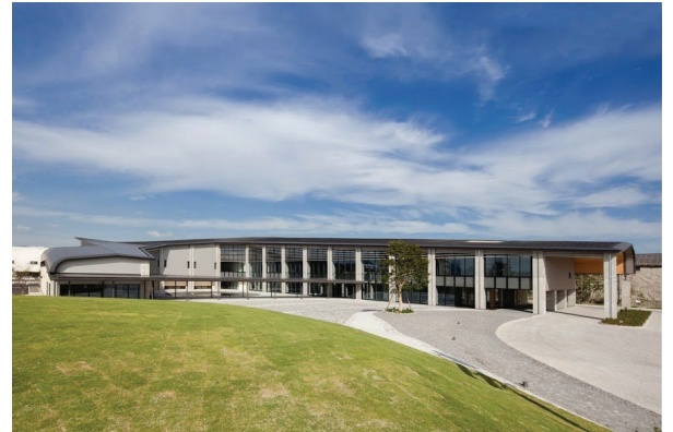
フソウテクノセンターの外観
