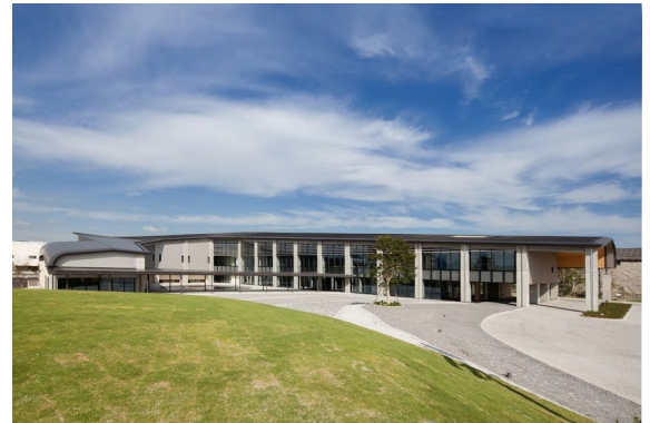
フソウテクノセンターの外観
