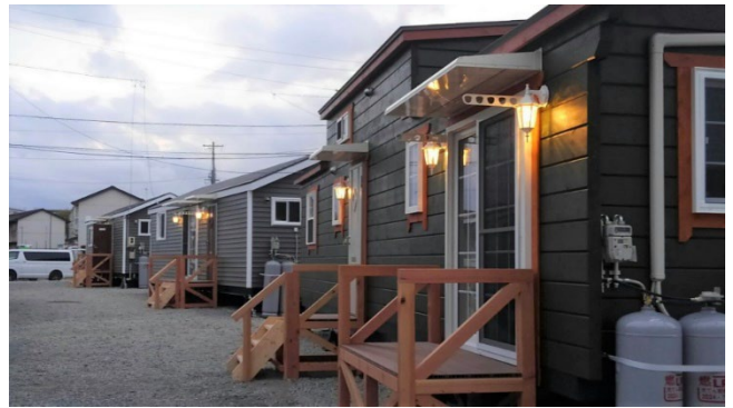
仮設住宅（トレーラーハウス）の様子（長野県）
