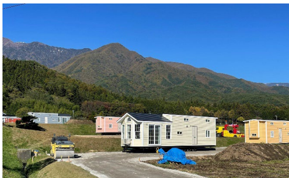
トレーラーハウス設置の様子（長野県飯島町）
