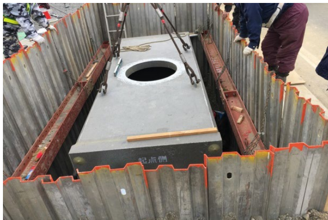
無電柱化工事（CCBOX 設置中）の様子
