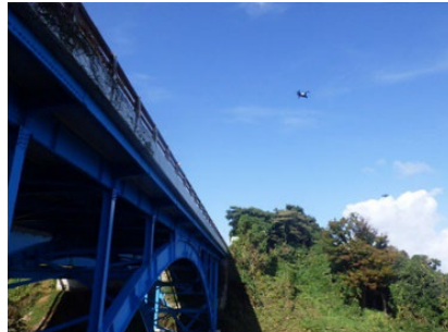
現場でのドローン撮影
