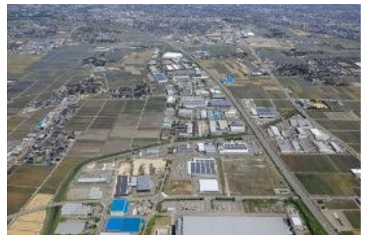
水田に囲まれた工業団地
