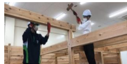
木造仮設住宅の建設の様子
