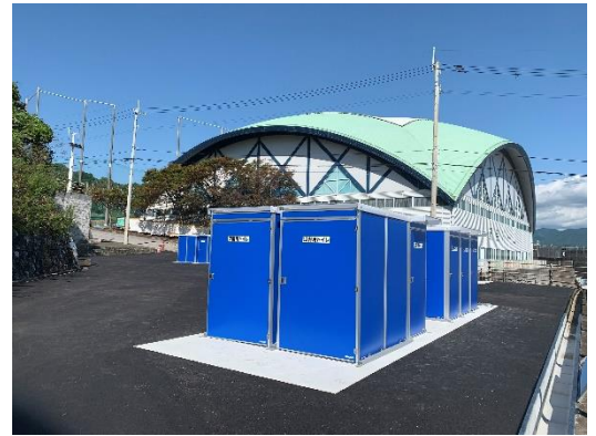
設置事例（安芸市営球場）
