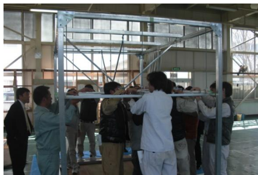
耐震天井施工研修会
