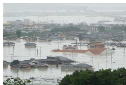
被災した真備町地区
