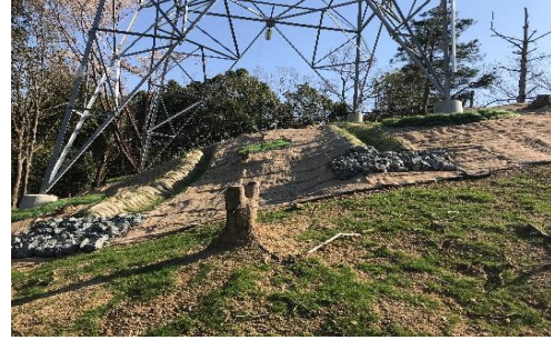
KODOBOKU 技術を活用した現場施工例
