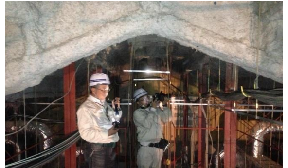
キャットウォークからの天井裏調査
