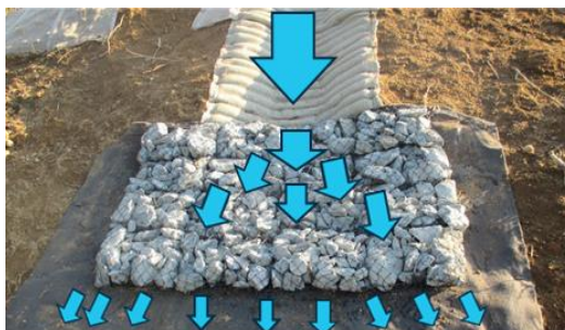
ストーンバッグによる流末処理
