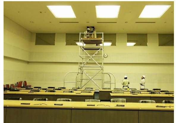
仮設足場による点検口からの天井裏調査
