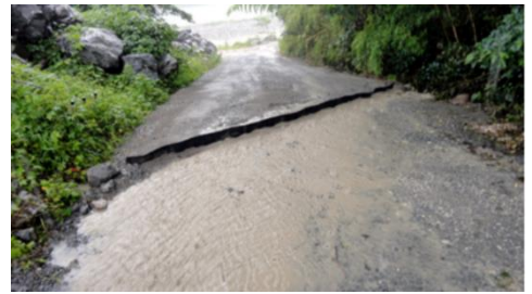
上部方向に流れている雨がブンサンベルトにより左右に排水され、路面の浸食を防ぐ
