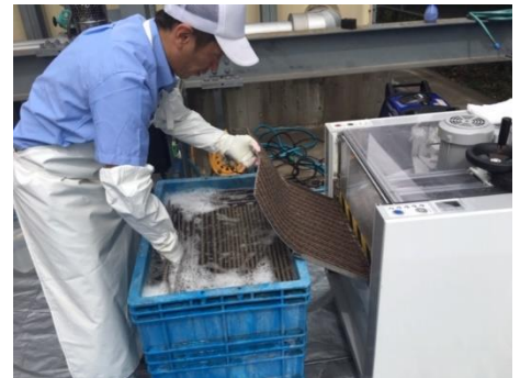
リセット施工の様子
