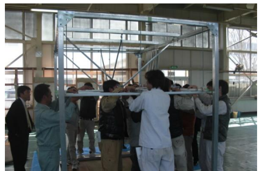
耐震天井施工研修会
