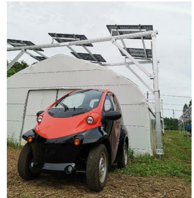
新たに導入された太陽光パネルと 超小型電気自動車
