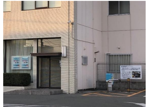
駐車場等、銀行の敷地内に設置
