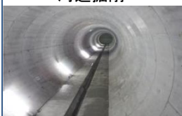
雨水貯留・排水施設整備
