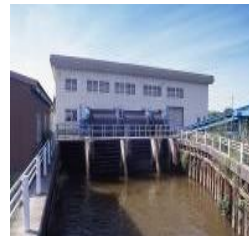
排水機場の整備
