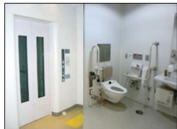
左:エレベーター、右:多目的トイレ
