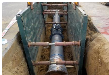
水道基幹管路の耐震化
