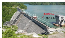
治水ダムの建設・再生
