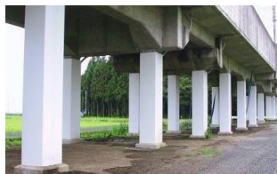
鋼板巻きによる高架橋の耐震補強
