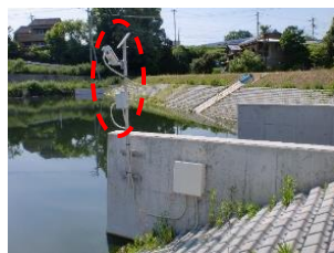
水位計等遠隔監視機器の設置
