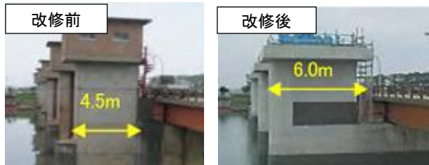
頭首工の耐震強化
