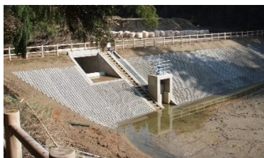
農業用ため池の整備
