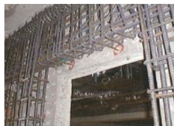
下水処理場の耐震化
