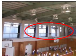
体育館への空調設置
