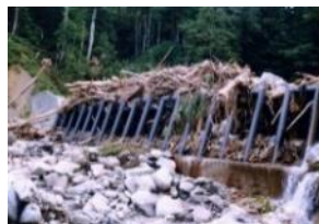
流木捕捉式治山ダムの設置
