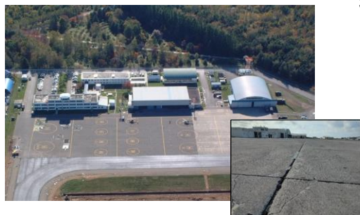
エプロンの劣化
