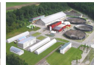
バイオガス発電・熱利用
