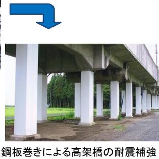
鋼板巻きによる高架橋の耐震補強
