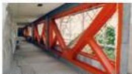
鉄骨ブレースによる壁の補強
