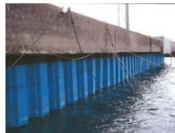
岸壁、鋼製矢板の腐食対策
