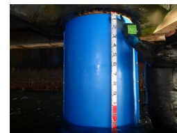
鋼管杭の被覆防食の更新
