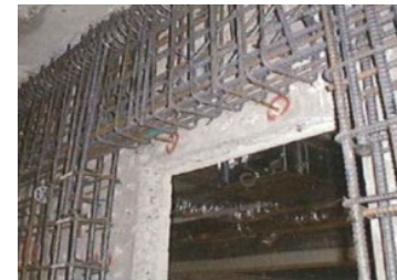
下水処理場の耐震化
