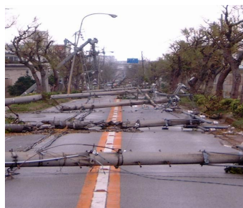
電柱の倒壊による道路閉塞
