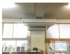
特別教室への空調設置
