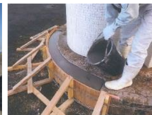
▲亀裂補修(環境遮断)
