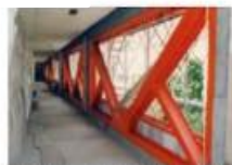
鉄骨ブレースによる壁の補強
