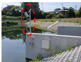
水位計等遠隔監視機器の設置
