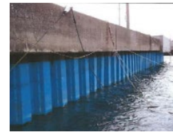
岸壁、鋼製矢板の腐食対策
