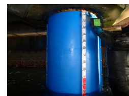
鋼管杭の被覆防食の更新
