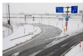
消融雪施設の整備
