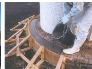
▲亀裂補修(環境遮断)
