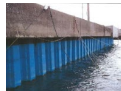
岸壁、鋼製矢板の腐食対策
