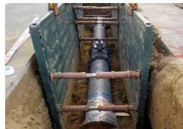
水道基幹管路の耐震化
