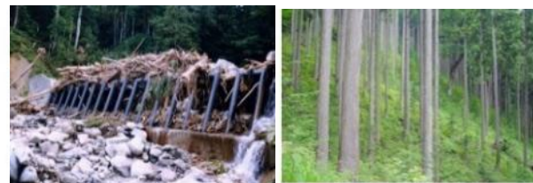
流木捕捉式治山ダムの設置
