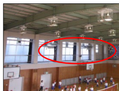
体育館への空調設置
