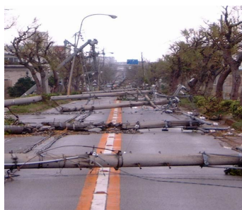
電柱の倒壊による道路閉塞
