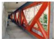
鉄骨ブレースによる壁の補強
