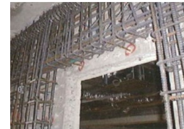
下水処理場の耐震化
