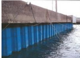
岸壁、鋼製矢板の 腐食対策
