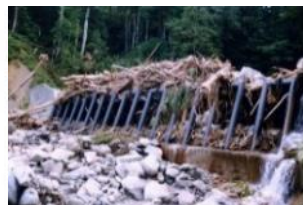
流水捕捉式治山ダムの設置
