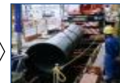
基幹管路の耐震化
