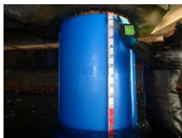
鋼管杭の被覆防食の更新
