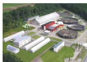
バイオガス発電・熱利用
