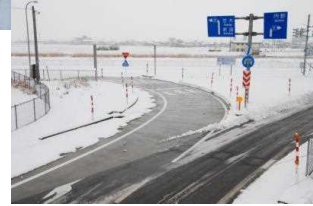
消融雪施設の整備
