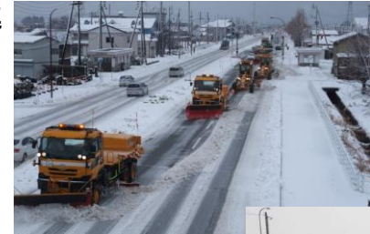
除雪機械の整備
