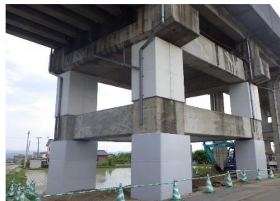
鋼板巻きによるラーメン橋台の耐震対策
