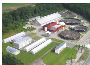
バイオガス発電・熱利用
