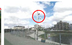
監視カメラの設置
