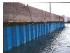
岸壁・鋼製矢板の腐食対策
