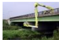
橋梁点検車を使った 橋梁点検
