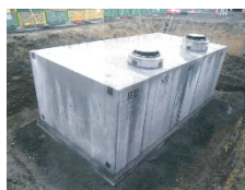
耐震性貯水槽
