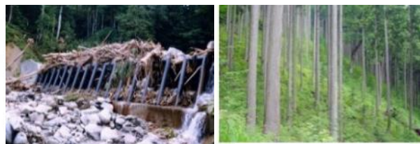
流木捕捉式治山ダムの設置
