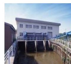
排水機場の整備
