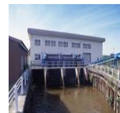
排水機場の整備
