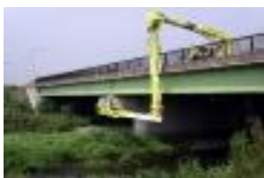
橋梁点検車を使った 橋梁点検
