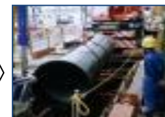
基幹管路の耐震化
