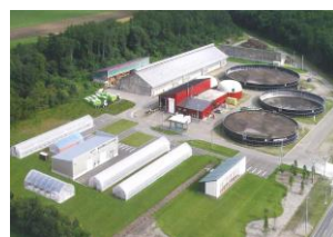
バイオガス発電・熱利用
