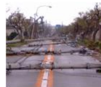
電柱の倒壊による道路閉塞
