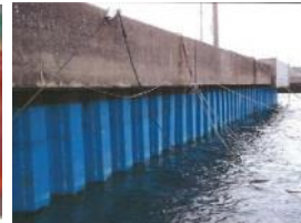
岸壁、鋼製矢板の 腐食対策
