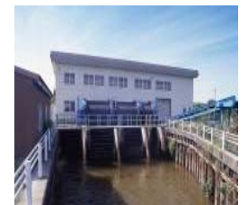
排水機場の整備
