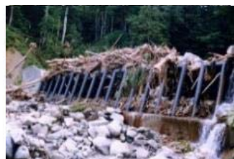
流木捕捉式治山ダムの設置
