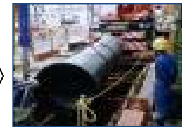
基幹管路の耐震化
