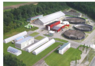
バイオガス発電・熱利用
