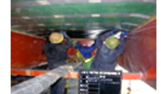
炭素繊維シート による補修
