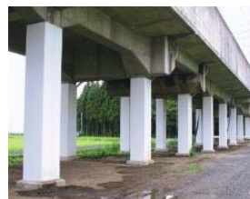
鋼板巻きによる耐震対策
