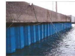
岸壁、鋼製矢板の腐食対策
