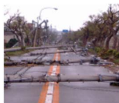
電柱の倒壊による道路閉塞
