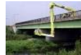
橋梁点検車を使った 橋梁点検
