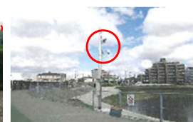
監視カメラの設置
