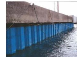
岸壁・鋼製矢板の腐食対策
