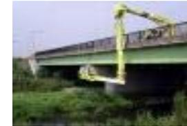
橋梁点検車を使った橋梁点検
