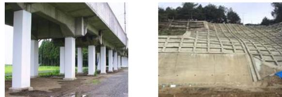
【鋼板巻きによる耐震対策】 【法面防護工による土砂流入防止対策】
