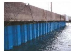
岸壁、鋼製矢板の腐食対策
