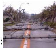
電柱の倒壊による道路閉塞
