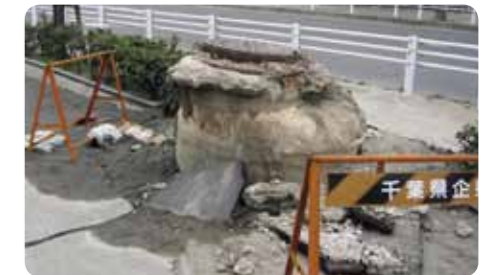
2011年／東日本大震災／浦安市高洲地区マンホール被害（消防科学総合センター）
