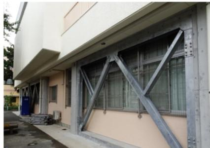
写真: 耐震補強工事後
