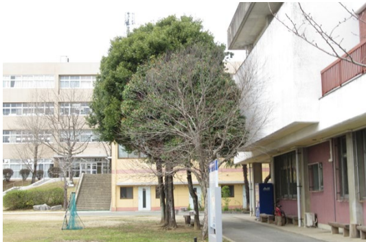
写真: 耐震補強工事前
