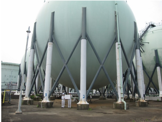
球形貯槽(耐震補強前)
