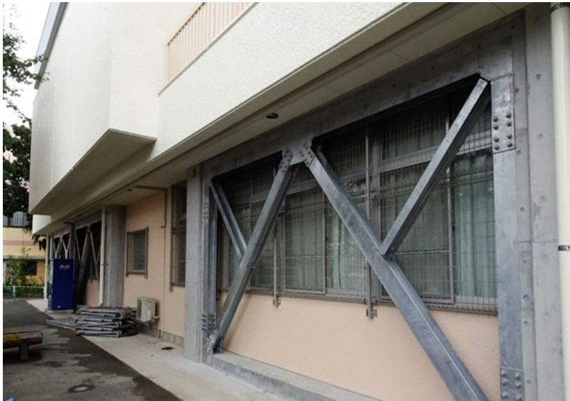
写真: 耐震補強工事後
