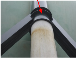
球形貯槽を支える脚部の補強対策
