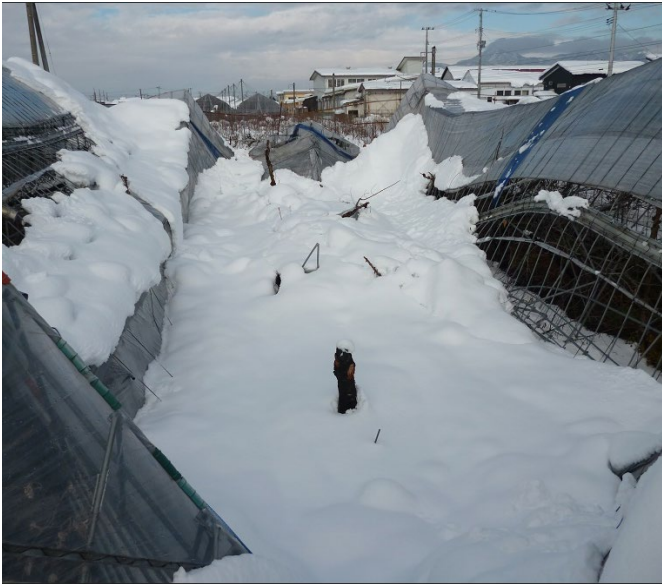
農業用ハウスの補強対策未実施
