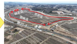
整備後(令和5年2月撮影)
