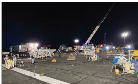
【滑走路の耐震対策 施工状況】
