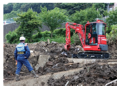
○重機で土砂排除【長野県大隊】
