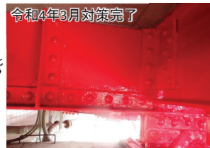
腐食除去・再塗装
