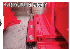
再塗装、アンカーボルトの設置
