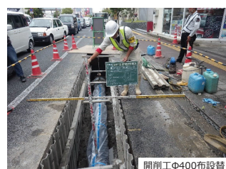
開削工Φ400布設替
