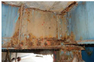
主桁の腐食
