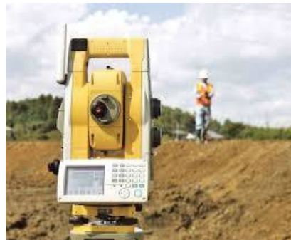
【トータルステーションの測量】
