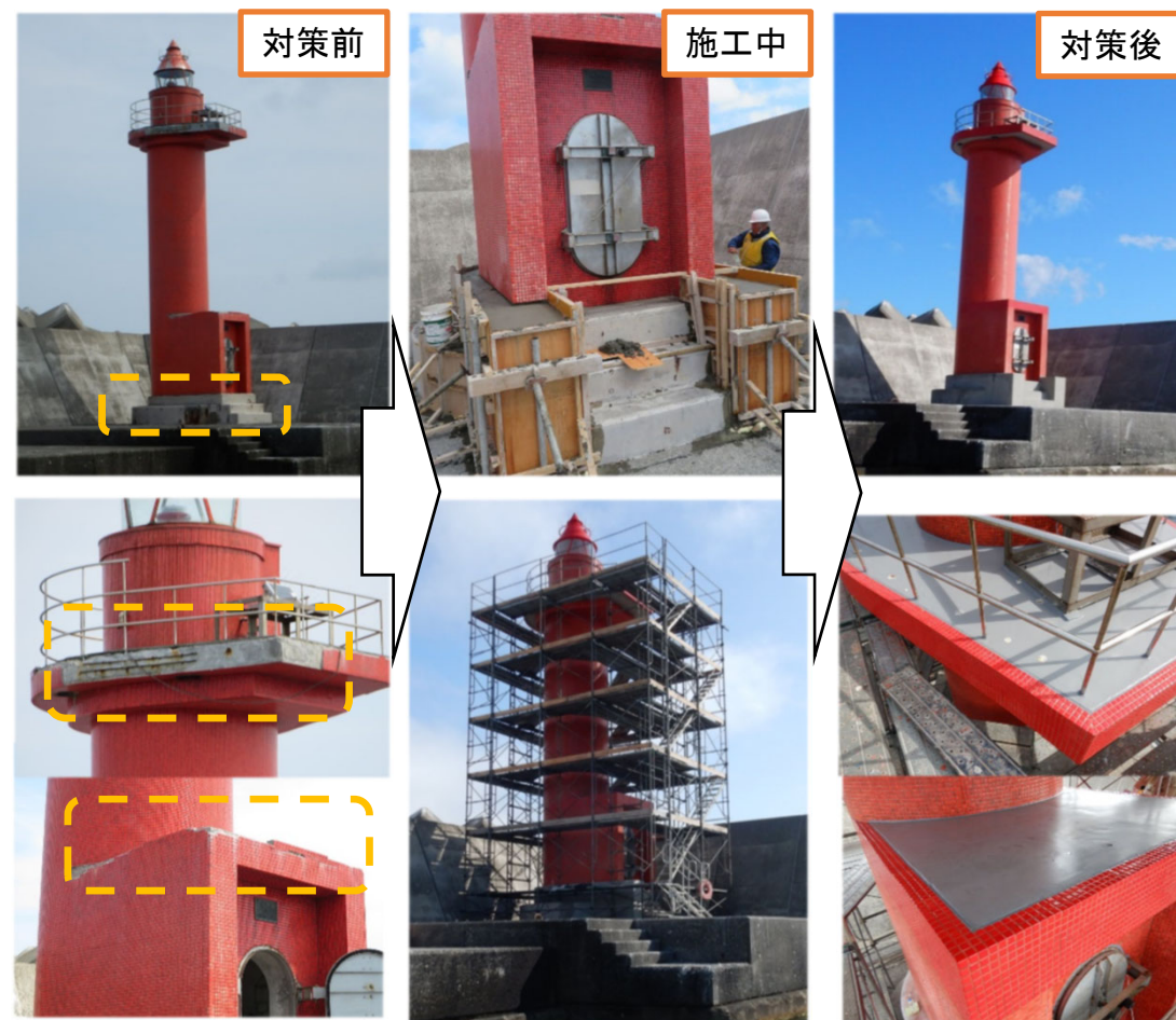
稚内港北副防波堤東灯台
