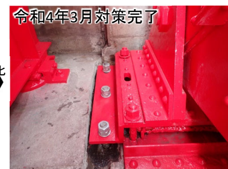
再塗装、アンカーボルトの設置
