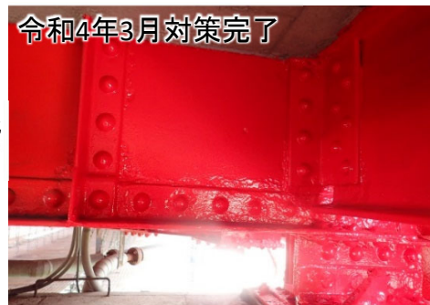
腐食除去・再塗装
