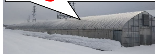
農業用ハウスの補強対策済み
