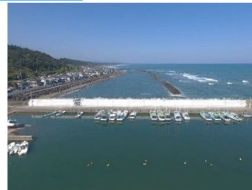
北防波堤護岸(改良)
