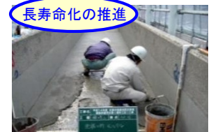
開水路の補修
