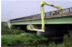
橋梁点検車を使った橋梁点検
