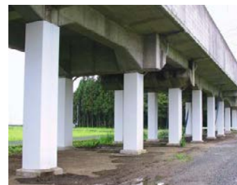
【鋼板巻きによる耐震対策】
