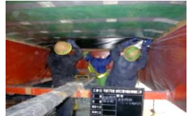
炭素繊維シートによる補修
