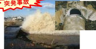
パイプラインの破裂による用水供給機能の停止
