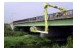
橋梁点検車を使った橋梁点検
