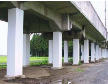
【鋼板巻きによる耐震対策】
