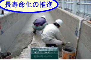
開水路の補修
