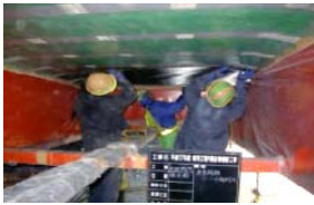
炭素繊維シートによる補修
