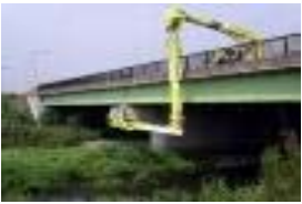
橋梁点検車を使った橋梁点検
