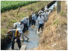
水路の泥上げ
