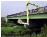
橋梁点検車を使った橋梁点検
