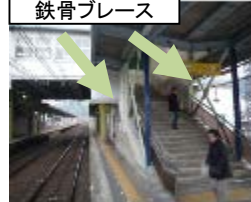
橋上駅の補強
