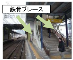
橋上駅の補強
