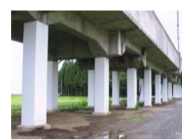
高架橋の補強
