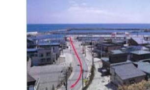
漁港から高台への避難路の整備
