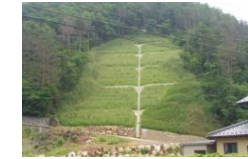
崩壊地(発生源)の復旧・予防
