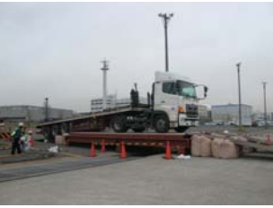
川崎港東扇島 応急復旧訓練
