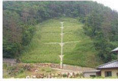
崩壊地(発生源)の復旧・予防
