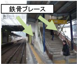
橋上駅の補強
