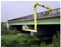
橋梁点検車を使った橋梁点検
