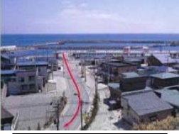
漁港から高台への避難路の整備
