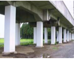
高架橋の補強
