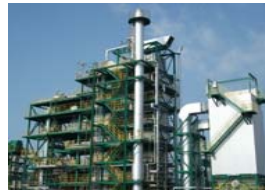
木質バイオマス発電所
